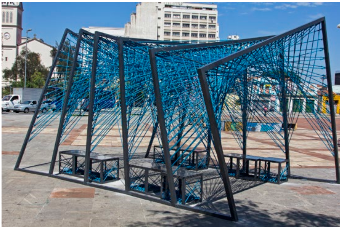
Trenzado, mobiliario urbano, con función de sombra y de permanencia, fabricado en estructura metálica y cuerdas de poliéster. Foto: Rogério Canella
