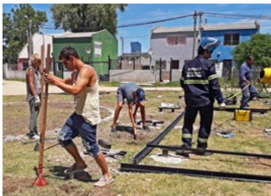
La comunidad construyendo su plaza.
