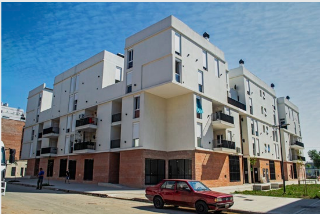
Viviendas nuevas en el conjunto Papa Francisco. Foto: equipo coordinación Villa 20
