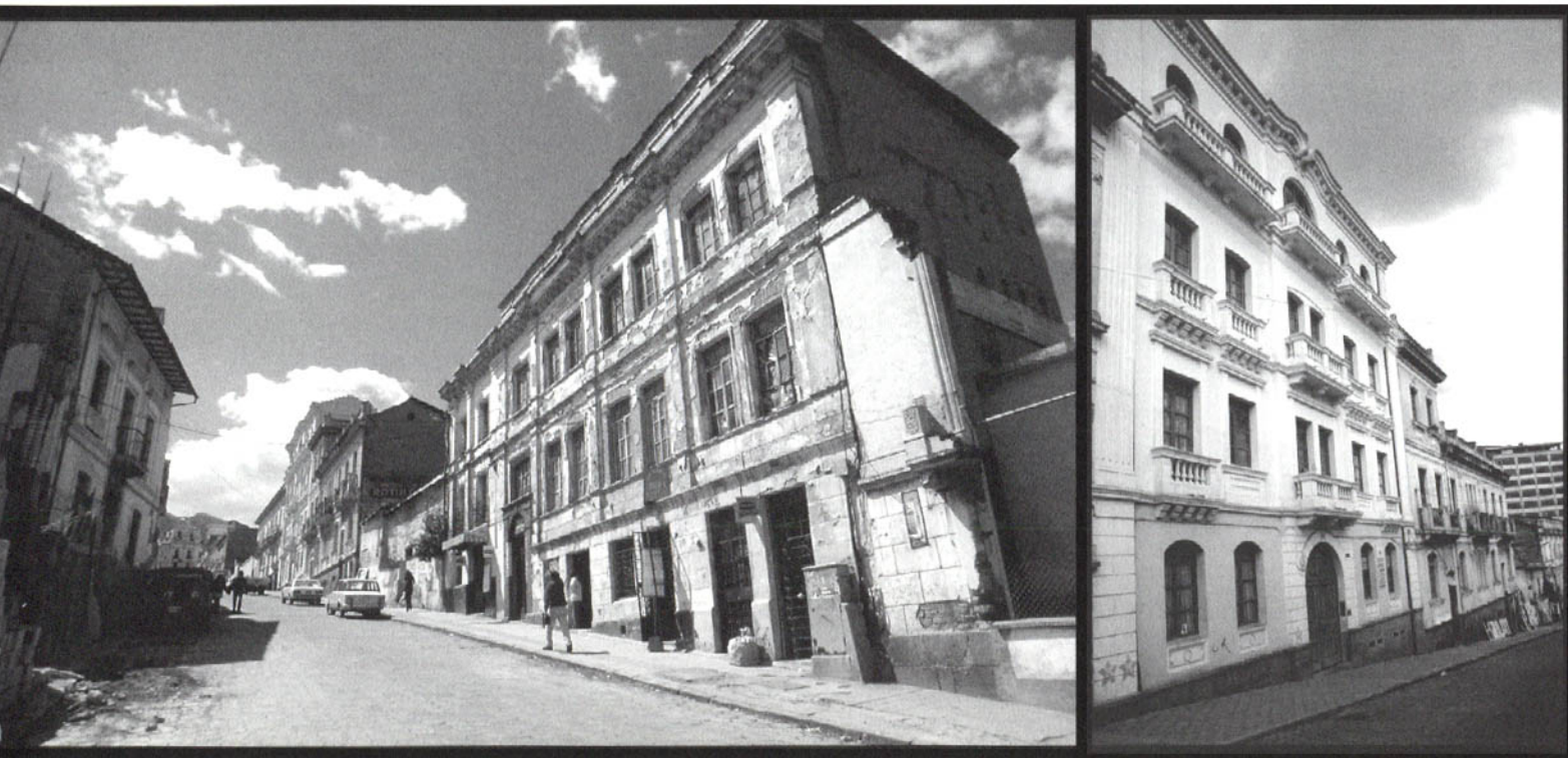
Antes y después. La calle Caldas es uno de los ejes donde se restauran edificios para vivienda social.
