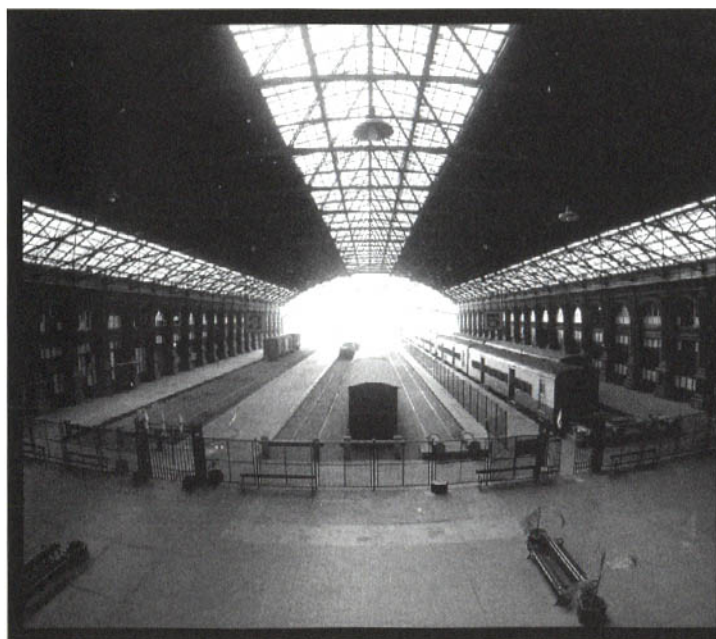
Nave central de la Estación Artigas.
