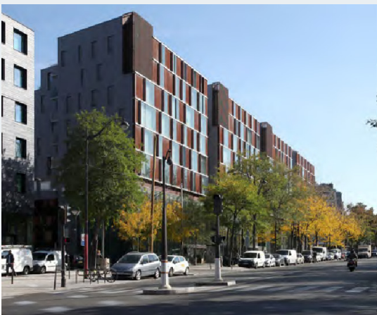
Edificio de viviendas sociales de París Habitat, Avenue de la Porte Montmartre, París 18 o
