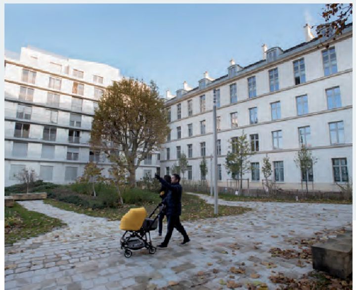
Caserne de Reuilly, patio empedrado
