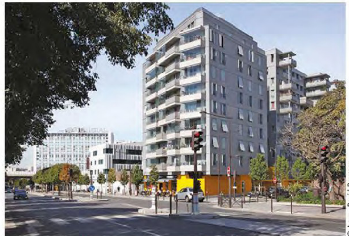
Logements Paris Habitat - boulevard du Bois-le-Prêtre, Paris 17 e
