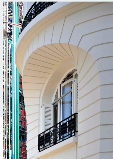
Detalle de la modénature de la fachada/ventana
