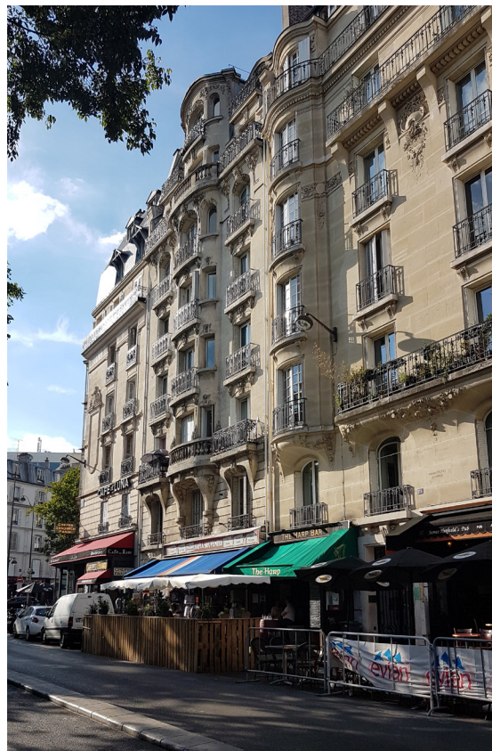
Edificio de viviendas sociales de Paris Habitat - Boulevard de Clichy, Paris 18 e
