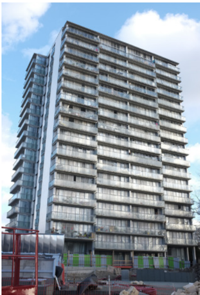
Bois le Prêtre Tower, Equerre d'argent, Paris 17 e
