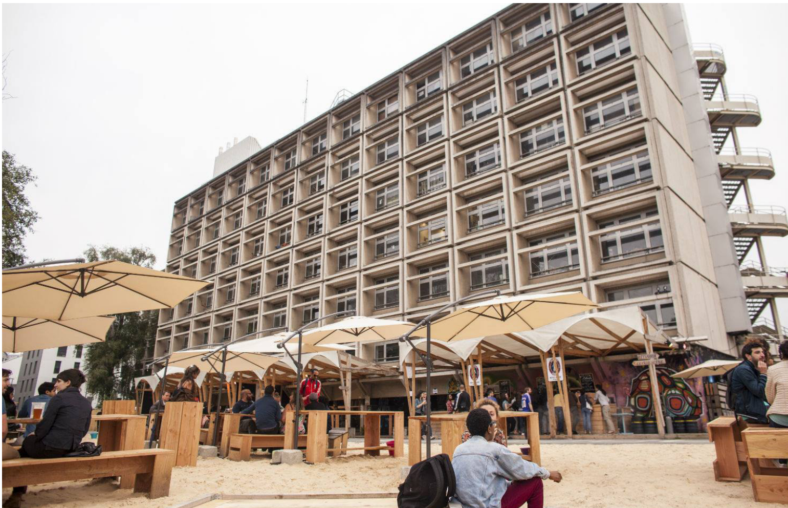
6B, lugar de trabajo autogestionado para la cultura y los intercambios instalado en un antiguo edificio industrial de 7,000 m 2 , Saint-Denis
