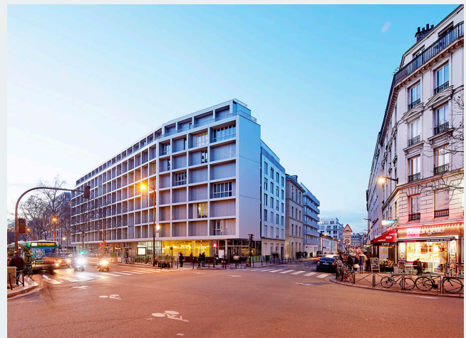
«Caserne de Reuilly» de la calle Reuilly, edificios de estudiantes y viviendas sociales
