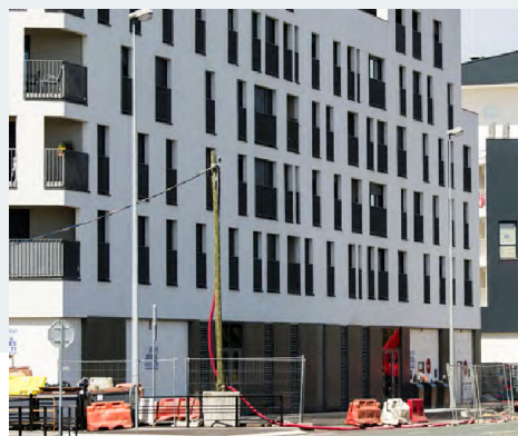
Construcción de un edificio de viviendas sociales en un barrio degradado
