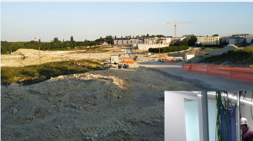
Vista de la obra, junio de 2020
