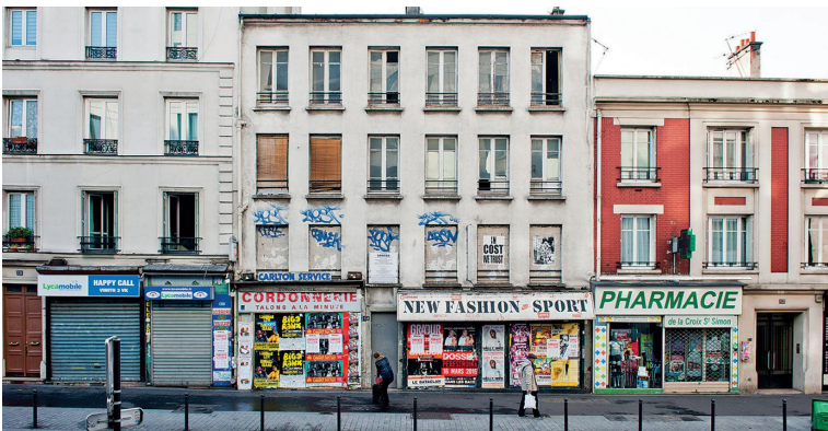
Edificio de viviendas precarias antes de su renovación, rue d'Avron, París 20
