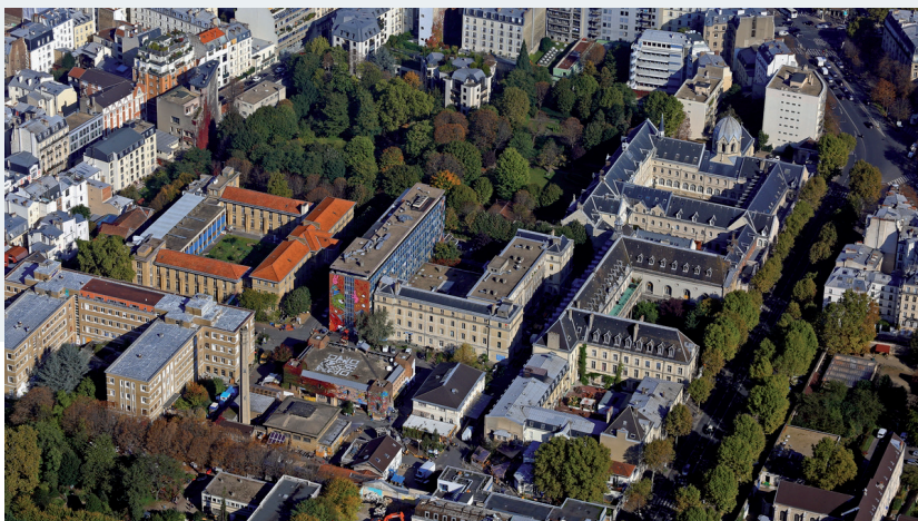
Vista aérea del antiguo Hospital Saint-Vincent de Paul, París 13e
