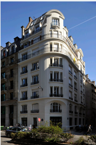
Fachada principal 2 rue Beaubourg
