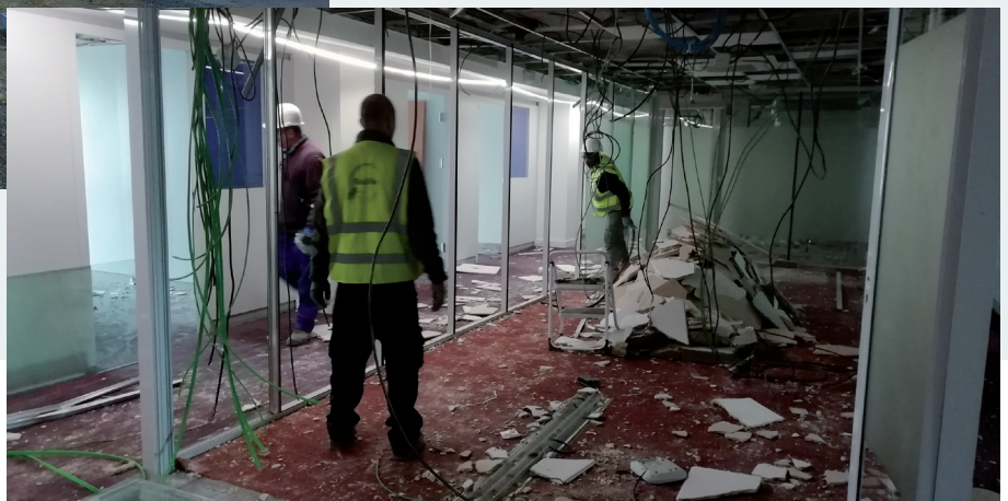
Eliminación de los tabiques de las aulas
