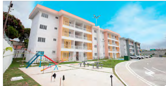
Obra 4: Residencial General Rodrigo Otávio
