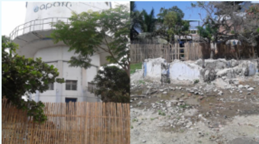
Figura 4. Daños a la infraestructura hídrica. Antes y después del terremoto de Manabí, Ecuador, 2016
