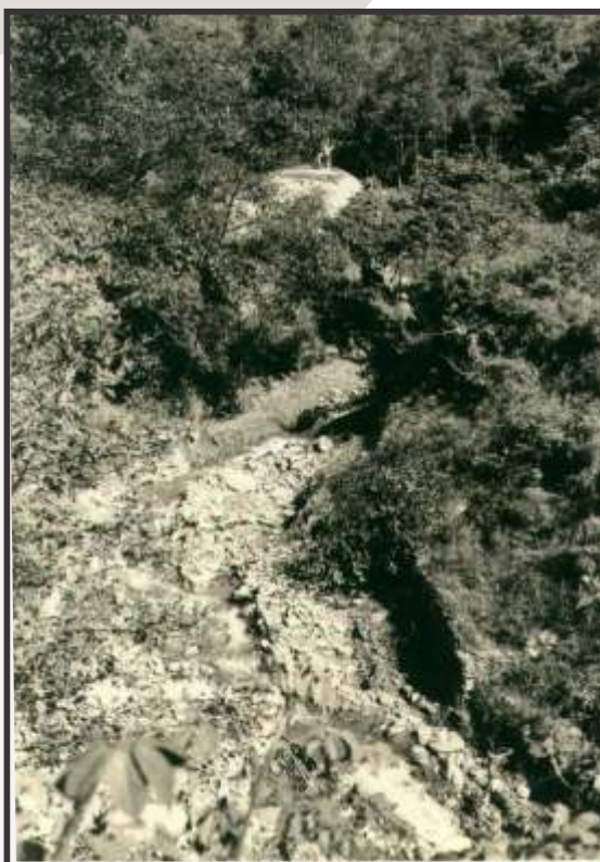
Figura 50. Comparación de fotografías antes (1967) y después (1986) del proyecto de control de erosión en el tramo Hm 2+50. Izquierda: Inestabilidad del lecho debido a erosión del cauce y márgenes. Derecha: Estabilidad del lecho producida por el escalonamiento del cauce con las obras de control. Fuente: Hernández (2006).
