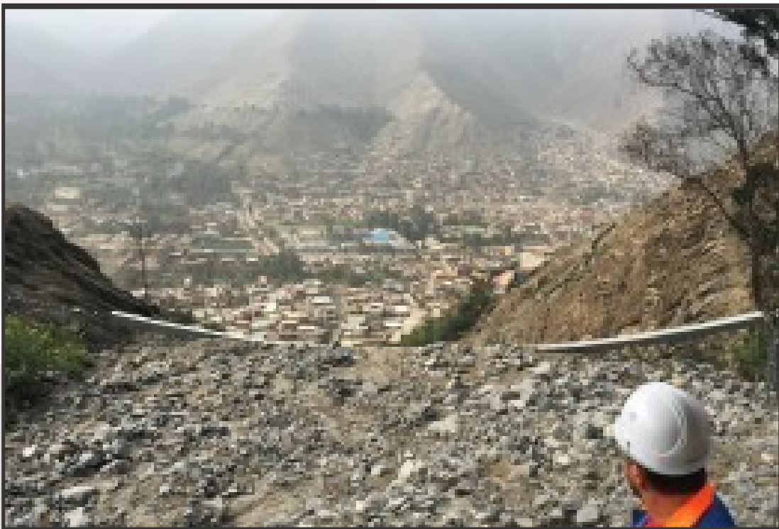
Figura 19. Vista hacia aguas abajo de la segunda barrera mostrando la cercanía de la ciudad. Fuente: Geobruigg (2017a).
