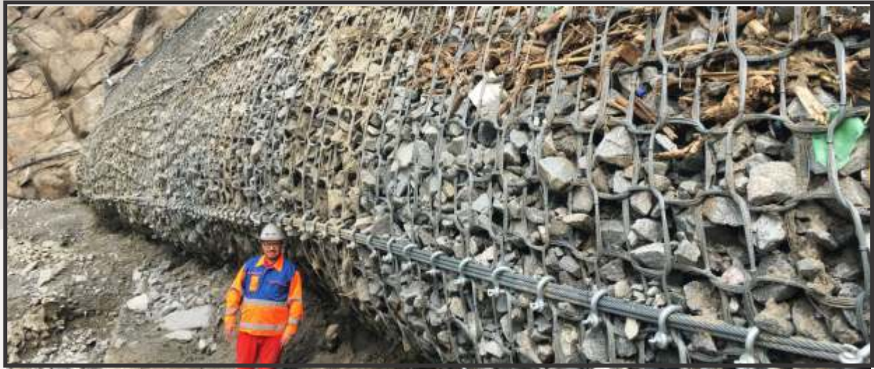
Figura 16. Vista del primer nivel de barreras donde se detuvieron aproximadamente 7.000 m 3 de sedimentos. Fuente: Geobruigg (2017a).
