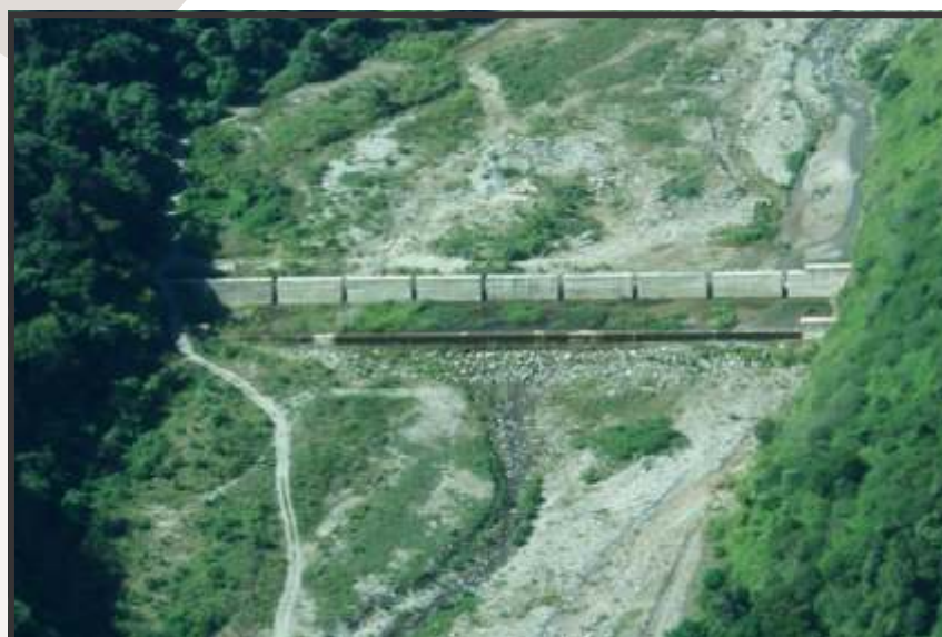
Figura 39. Vista aérea de la presa abierta de concreto ciclópeo de 5 m de altura construida en el río Naiguatá. Obsérvese las ranuras en el cuerpo de la presa y el contradique a unos 20 m del dique principal. El ancho del cauce en el sitio de presa es de 155 m. Fuente: Morassutti, 2010.
