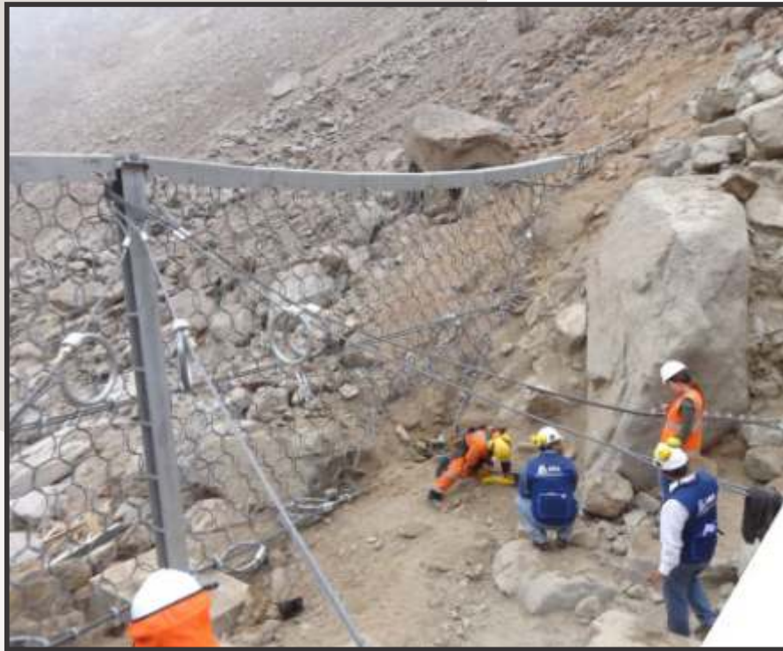
Figura 15. Vista lateral cercana del empotramiento de una de las barreras flexibles instaladas en uno de los barrancos de Chosica. Fuente: Geobruigg (2017a).
