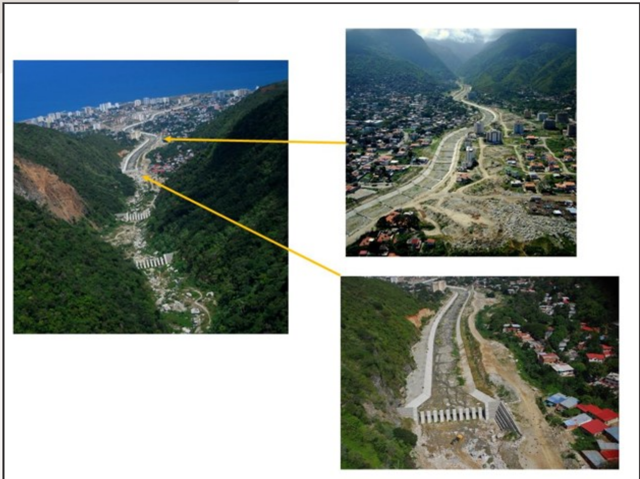
Figura 26. Vista aérea de las obras de control en el río San Julián, mostrando: a) el canal de fondo móvil protegido con traviesas para control de erosión y recubrimiento de concreto en las márgenes; y b) tres presas abiertas para retención de sedimentos. Fotografías a la izquierda y en el fondo son tomadas mirando hacia aguas abajo. Fotografía superior derecha es mirando hacia aguas arriba. Fuente: López y Courtel (2012).
