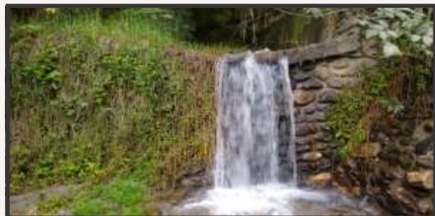
Figura 49. Diques en escalonamiento para control de erosión del lecho en quebrada La Virgen.
