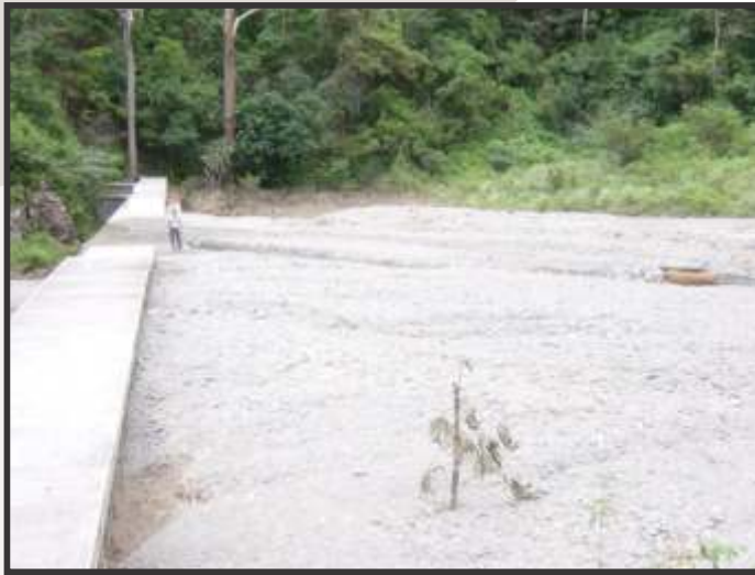
Figura 32. Fotografía del vaso totalmente sedimentado de la Presa N° 2 (izquierda) y erosión general al pie de la presa aguas abajo (derecha), debido al flujo de aguas claras durante la crecien de febrero del 2005. Fuente: López et al (2010).
