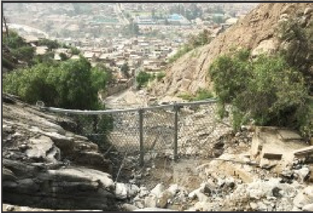
Figura 20. Vista hacia aguas abajo desde el cuarto nivel de las barreras, la cual no ha sido afectada por los deslaves, manteniendo intacta su capacidad de almacenamiento de sedimentos. Fuente: Geobrugg (2017a).
