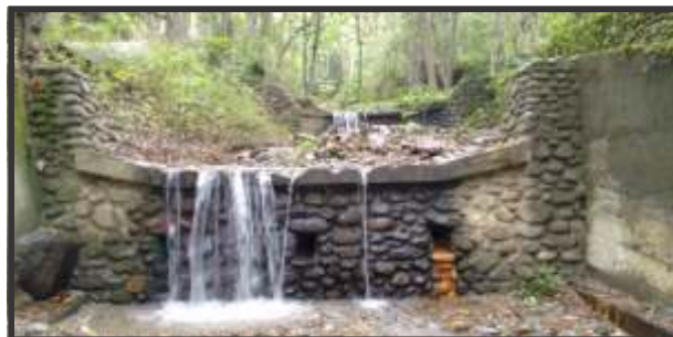
Figura 49. Diques en escalonamiento para control de erosión del lecho en quebrada La Virgen.
