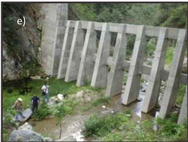
Figura 25. Fotografías de diferentes tipos de presas abiertas construidas en Vargas: a) presa ranurada, tipo rastrillo, de gaviones en quebrada Piedra Azul; b) presa de gaviones con ventanas en río Camurí Chico; c) presa tipo rastrillo de concreto armado en quebrada Guanape; d) presa tipo rastrillo de concreto armado en río San Julián; e) presa tipo enrejado de concreto armado en la quebrada San José de Galipán; y f) presa ranurada de concreto ciclópeo en la quebrada Curucutí.
