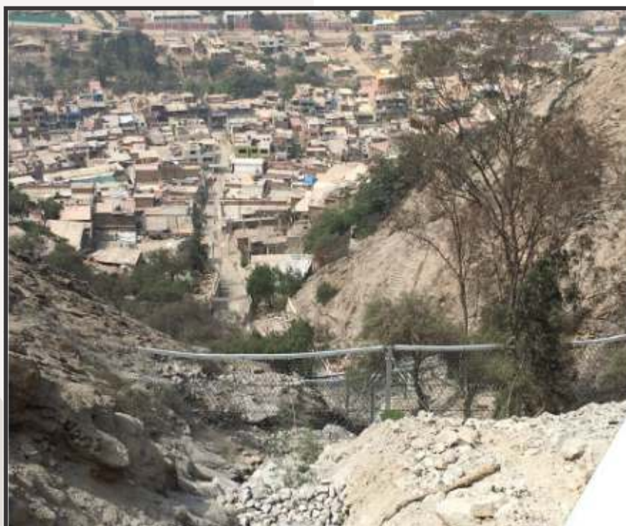
Figura 12. Vista desde aguas arriba de una barrera de protección en Chosica. Fuente: Geobruigg (2017a).
