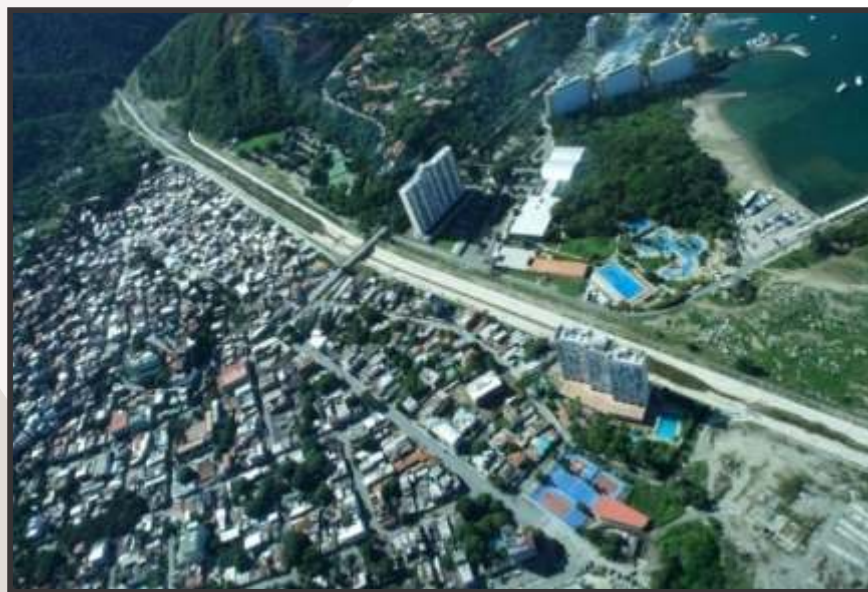
Figura 41. Vista aérea de la canalización del río Naiguatá. Obsérvese canalización en tierra con revestimiento de márgenes aguas arriba del puente y canalización en concreto aguas abajo del puente (dirección del flujo es de izquierda a derecha).
