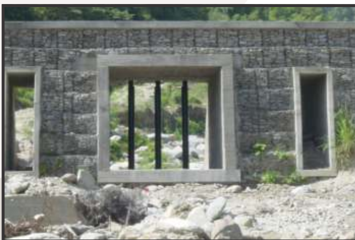
Figura 33. Vista frontal de la presa abierta, del tipo de ventanas, construida en gaviones sobre la quebrada Camurí Chico. La foto izquierda fue tomada después de su construcción. La foto derecha, tomada a principios de 2011, muestra el descenso del lecho en el orden de 3 m. por efectos de la degradación general del lecho causada por los flujos de aguas claras en la crecien de diciembre de 2010. Fuente: López et al (2010).
