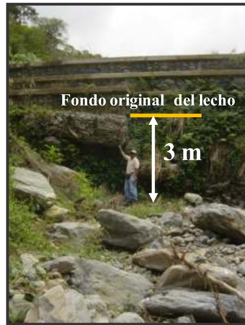
Figura 32. Fotografía del vaso totalmente sedimentado de la Presa N° 2 (izquierda) y erosión general al pie de la presa aguas abajo (derecha), debido al flujo de aguas claras durante la crecien de febrero del 2005. Fuente: López et al (2010).
