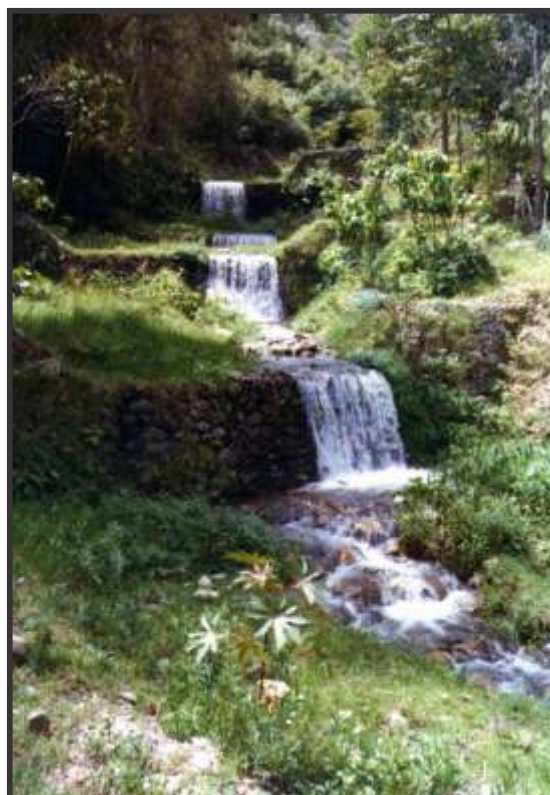
Figura 50. Comparación de fotografías antes (1967) y después (1986) del proyecto de control de erosión en el tramo Hm 2+50. Izquierda: Inestabilidad del lecho debido a erosión del cauce y márgenes. Derecha: Estabilidad del lecho producida por el escalonamiento del cauce con las obras de control. Fuente: Hernández (2006).
