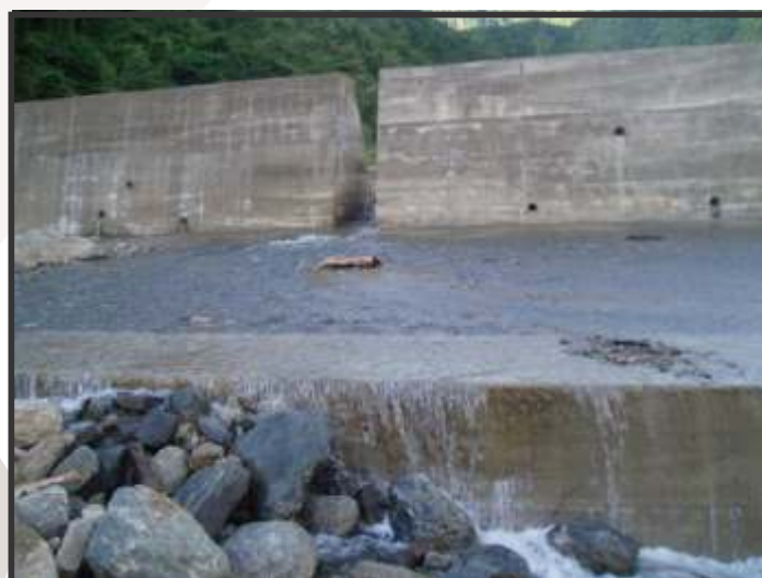
Figura 40. Vista frontal de la presa abierta de concreto ciclópeo de 5 m de altura construida en el río Naiguatá. Fuente: PROHIDRA (2001a).
