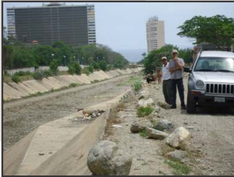
Figura 42. Vista hacia aguas abajo de la canalización construida sobre el río Naiguatá, en el tramo superior donde el canal es de fondo móvil con recubrimiento de taludes en concreto ciclópeo. (Foto: J. L. López).
