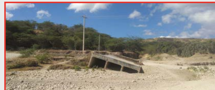
2 Capacidad hidráulica superada
