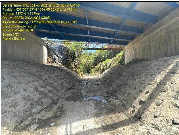
Cauce encauzado bajo el nuevo puente, con sección hidráulica ampliada para el paso de crecidas.
