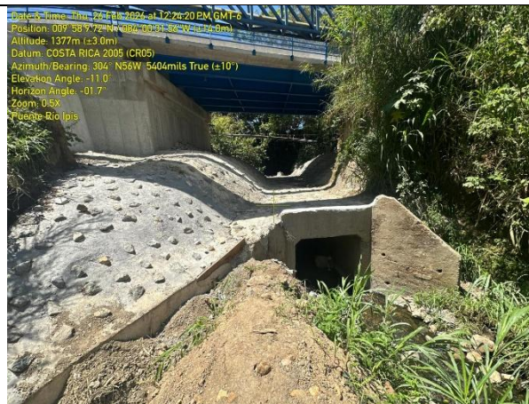
Protección contra socavación en la margen del río, con obra de disipación a la salida del paso.
