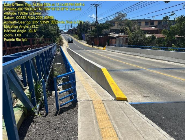
Después: nuevo tablero con acera, franja podotáctil, cordón y barreras de seguridad.
