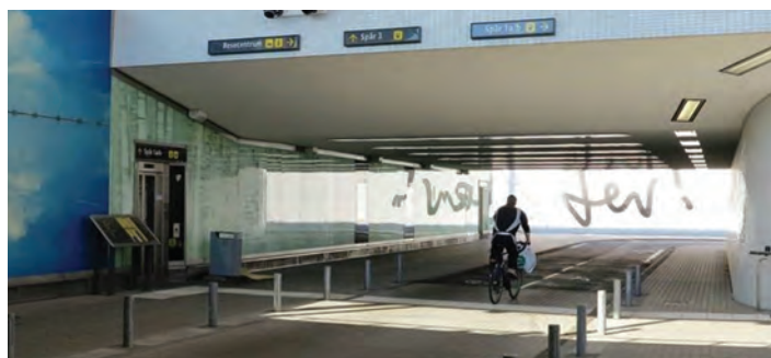
Imagen 94: Lev Tunnel, Suecia. Fuente: SmartCity Sweden.
