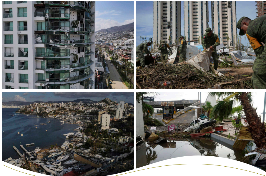
Figura 5: Daños causados por el huracán Otis
