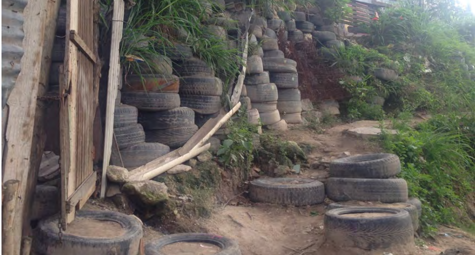
Foto 18: Muro de llantas existente, Villa Nueva
