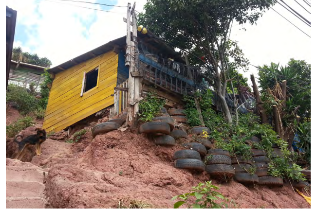
Foto 16: Mala práctica de adaptación en construcción de muro con llantas usadas, Villa Nueva
