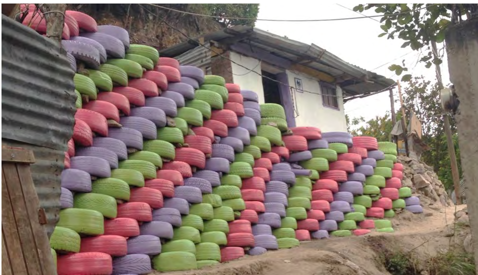
Foto 19: Construcción del nuevo muro de llantas, Villa Nueva
