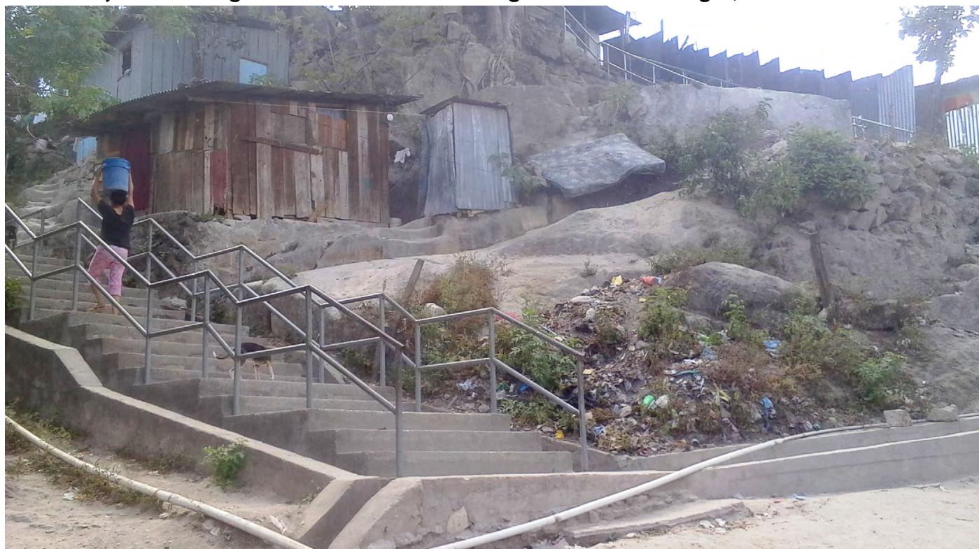
Foto 3: Mujer subiendo gradas recién construidas cargando un balde de agua, Los Pinos
