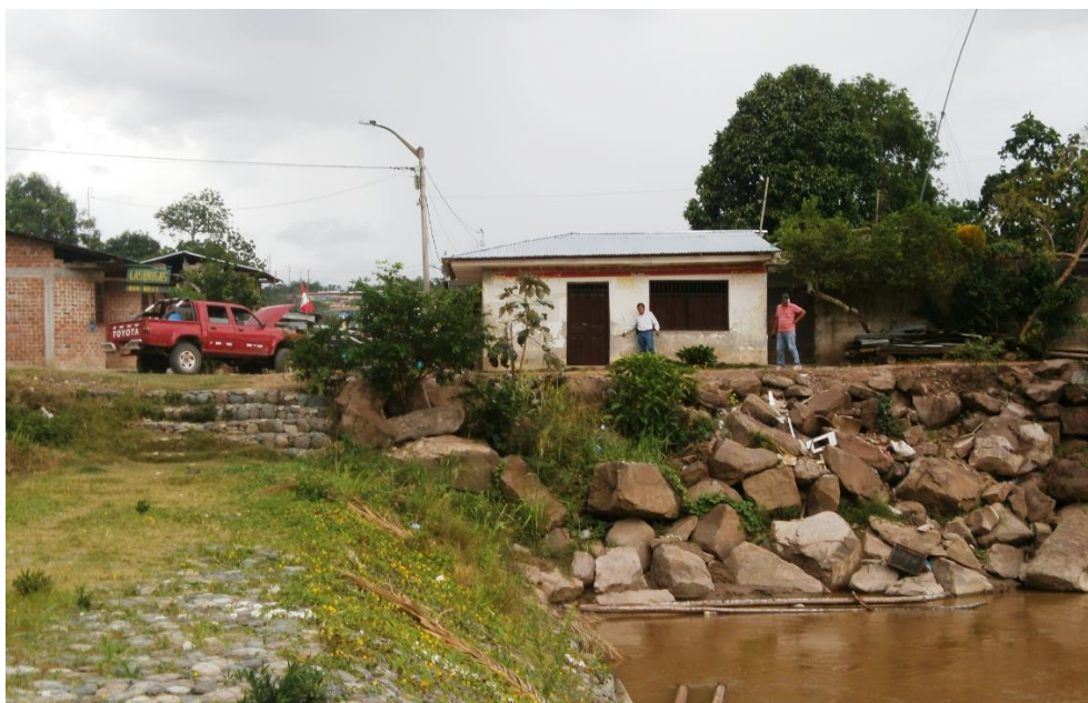
Gráfico 5. Marcas de una inundación histórica en el tramo de Campanilla (Cuenca del Huallaga)
