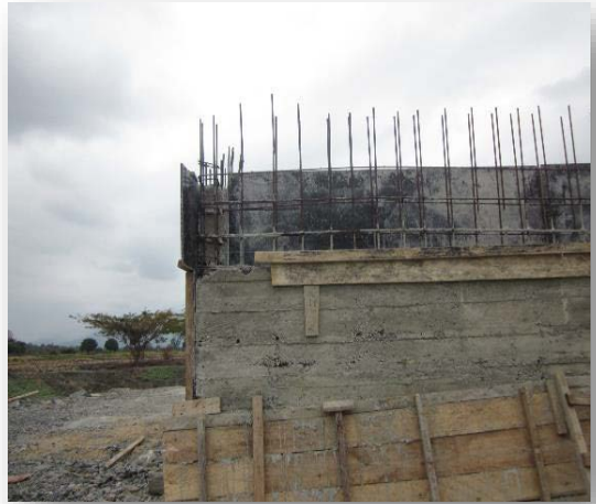
Arriba: Muro de hormigón de una planta de tratamiento de aguas residuales mencionada en el resumen de caso nº 3
