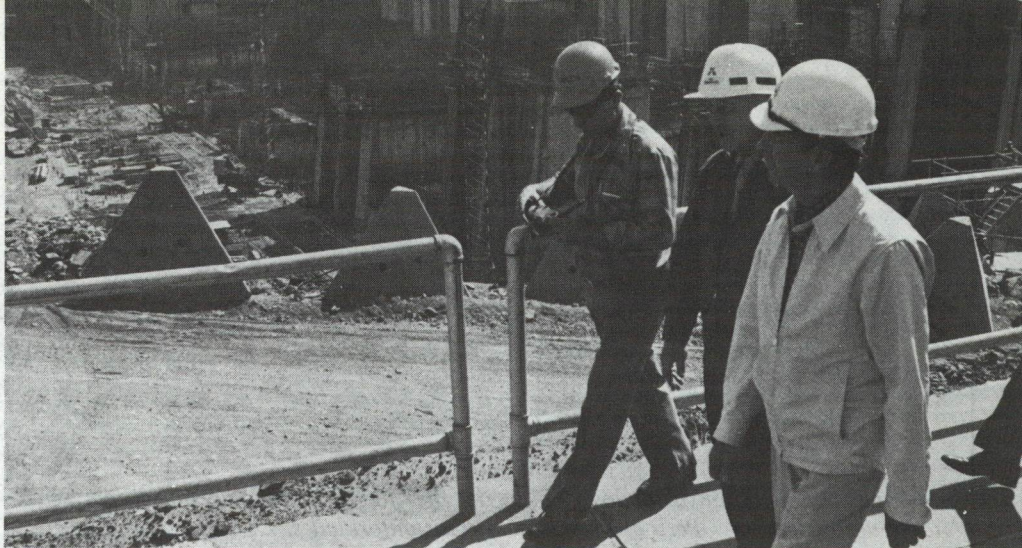
Durante su visita al Paraguay, el Presidente del BID, Antonio Ortiz Mena, visitó la gigantesca represa hidroeléctrica binacional de Itaipú, que dicho país construye conjuntamente con el Brasil. En la foto, el Sr. Ortiz Mena observa los trabajos, junto al Presidente de la Administración Nacional de Electricidad del Paraguay y Director Adjunto del Ente Binacional Itaipú, Enzo Debernardi.
