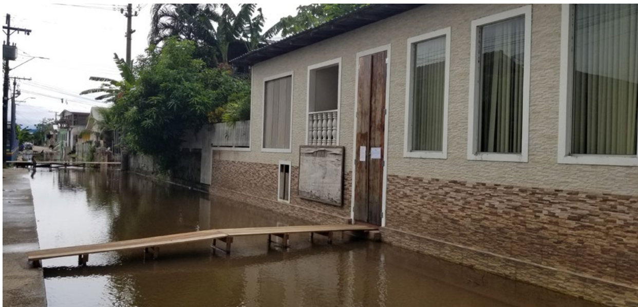
Andamios temporales llamados “marombas” colocados por la población durante una crecida del Río Amazonas en julio de 2025, Municipio de Careiro da Varzea, Región Metropolitana de Manaus, Brasil. (Fuente: archivo Cities LAB)
