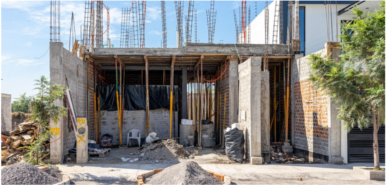
Vivienda en proceso de techado con proyección a ampliación vertical. (Fuente: Shutterstock)
