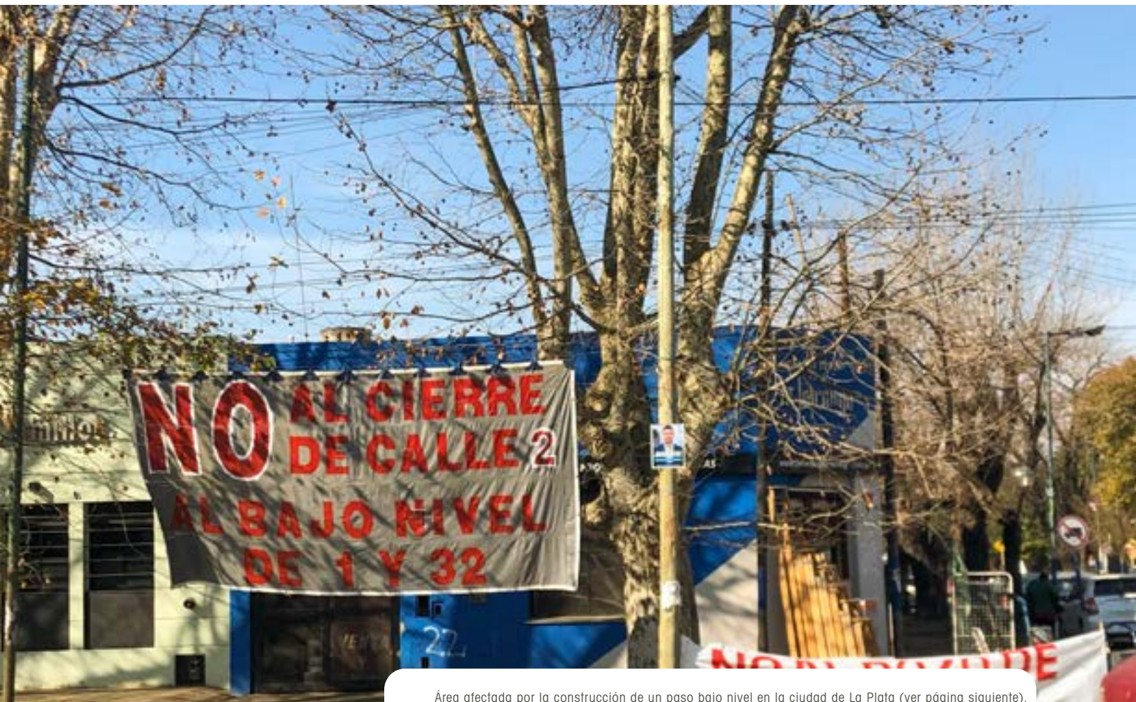
Área afectada por la construcción de un paso bajo nivel en la ciudad de La Plata (ver página siguiente).
