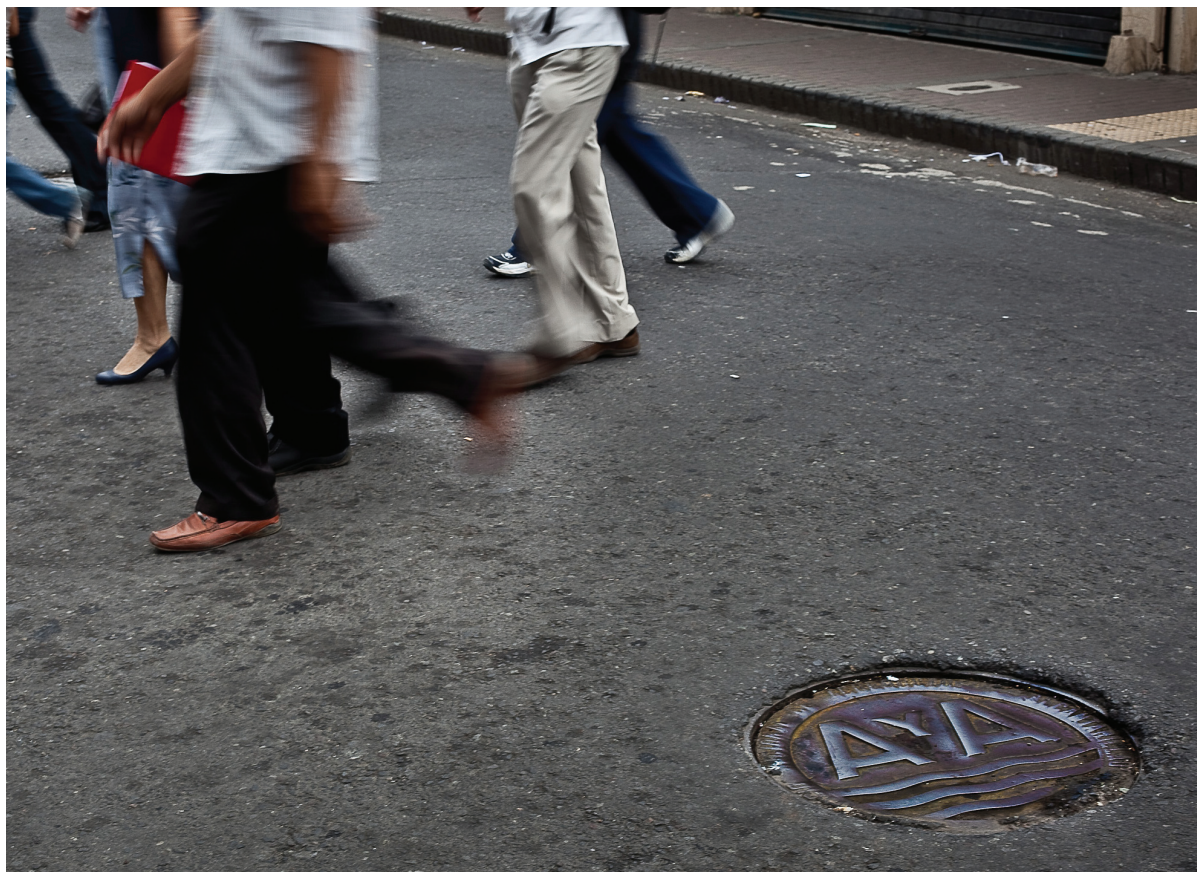
Alcantarillado. San José, Costa Rica
