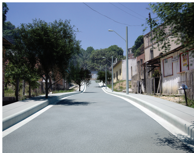
Mejoramiento de Vías. Barrio Jorge Teixeira. Manaus
