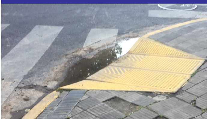
FIGURA 15. RAMPA DE VEREDA
