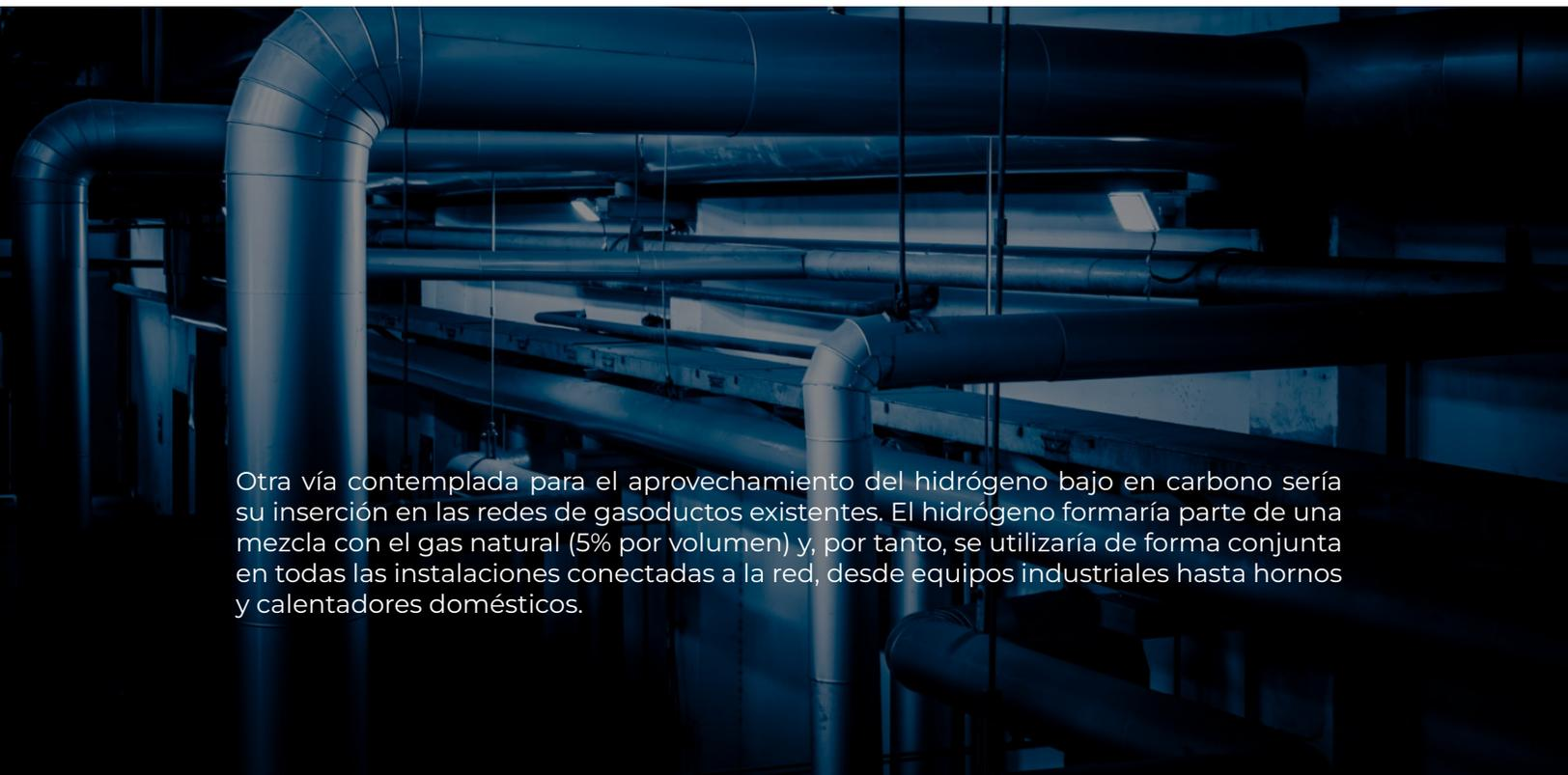
Otra vía contemplada para el aprovechamiento del hidrógeno bajo en carbono sería su inserción en las redes de gasoductos existentes. El hidrógeno formaría parte de una mezcla con el gas natural (5% por volumen) y, por tanto, se utilizaría de forma conjunta en todas las instalaciones conectadas a la red, desde equipos industriales hasta hornos y calentadores domésticos.
