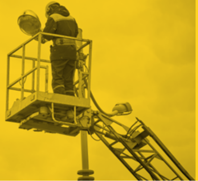
Figura 23: Reemplazo de luminarias por dispositivos LED. @ Tricky Shark . Stock.adobe.com
