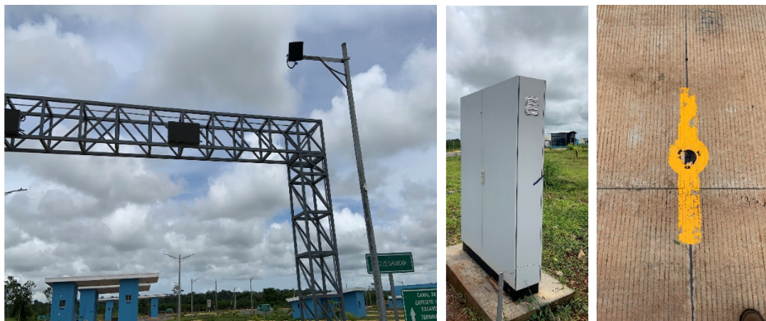
Arco con pantallas de indicación, antena RFID, gabinete de datos, sensor de estacionamiento vehicular, dispositivos instalados en el Puesto de Frontera de San Pancho, Nicaragua.
