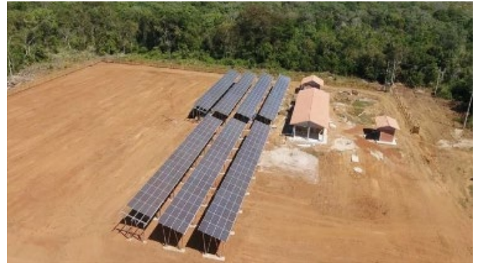
Desmonte de vegetación en una planta solar híbrida, (Solar - Diésel) con una potencia instalada de 168 KW pico, en Bolivia. Fuente: INEL, Proyecto El Remanso, Bolivia.
