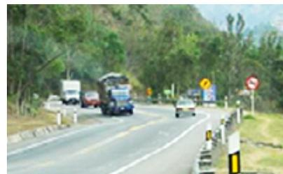
← En algunos casos se observó que debajo de las defensas metálicas se construyen bordillos con alturas superiores a 10 cm, lo que impide el trabajo normal de flexibilidad de las defensas y puede producir detenciones bruscas con alto impacto a los ocupantes de los vehículos.
