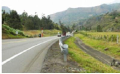
← En el p. k. 18+200 hay una defensa sin separadores ni postes quebradizos. La zona lateral es plana, con cunetas que pueden ser traspasables a excepción de los cabezales de la alcantarilla y el sitio de encauzamiento de las aguas en el punto de inicio. Termina en un dispositivo “cola de pez” en dirección al tráfico que puede producir el efecto cuchillo. Se podría reconsiderar su uso, ya que podría no ser necesaria.
