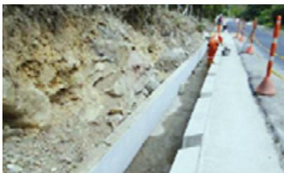
En el p. k. 45+000 se observaron canales de 75 cm de profundidad al borde de la vía, con bordillos de 30 cm y ranuras para paso del agua. El ancho de la berma de 80 cm. Estos bordillos se convierten en un obstáculo que al impactarse puede producir el vuelco. Si se requiere esa mayor sección hidráulica, la cuneta se puede cubrir con rejillas para hacerlas traspasables.
