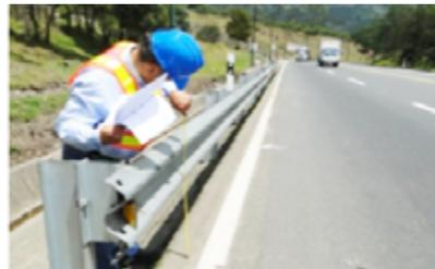
← Defensa metálica de 0,75 m de altura (p. k. 5+280), sin área de trabajo ya que los primeros ocho postes son de anclaje. Parece ser de encauzamiento y no de contención por la poca probabilidad de salida de la vía en ese sitio. Se podría reevaluar su necesidad.
