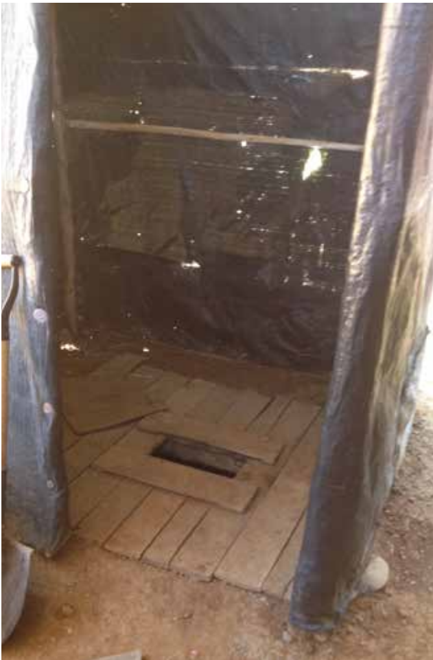
Ejemplo de letrina doméstica usualmente encontrada en áreas peri-urbanas de Perú. Foto cortesía de Water.org.
