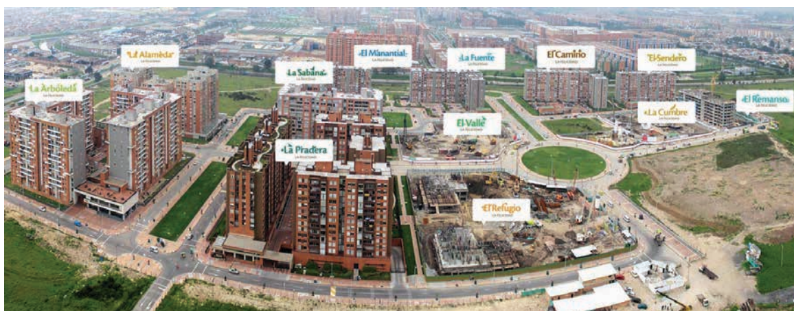
FIGURA 4.3. Avances de obra, abril de 2013
