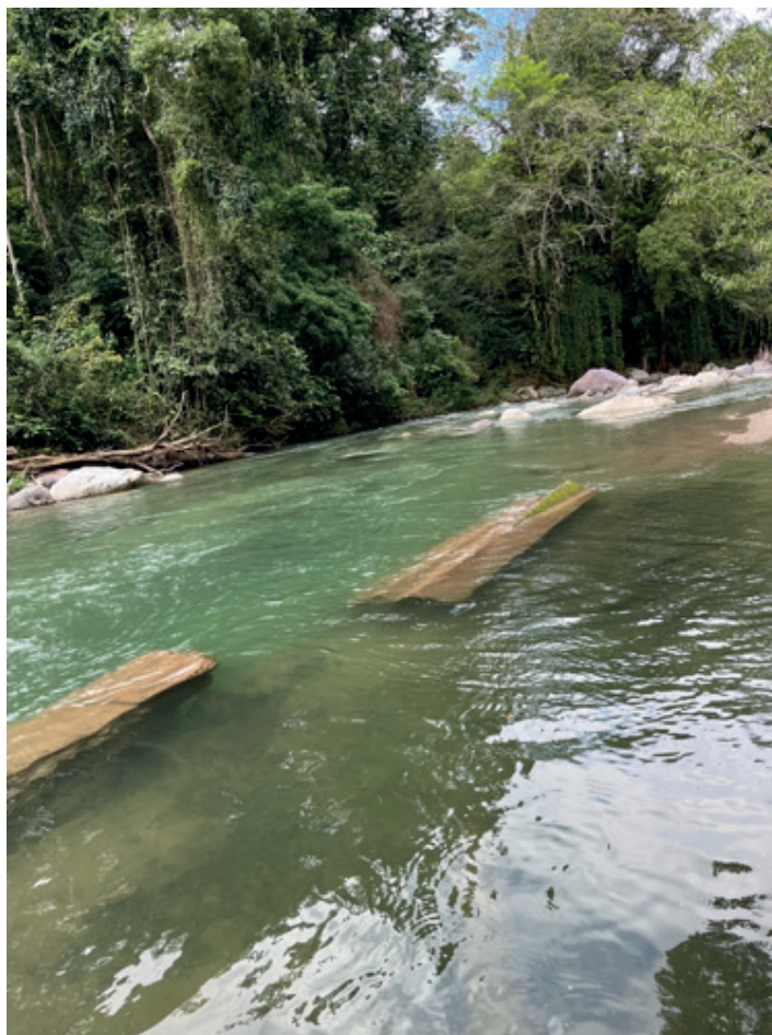
Imagen 7: Daños en infraestructura de captación, acueducto urbano La Ceiba
