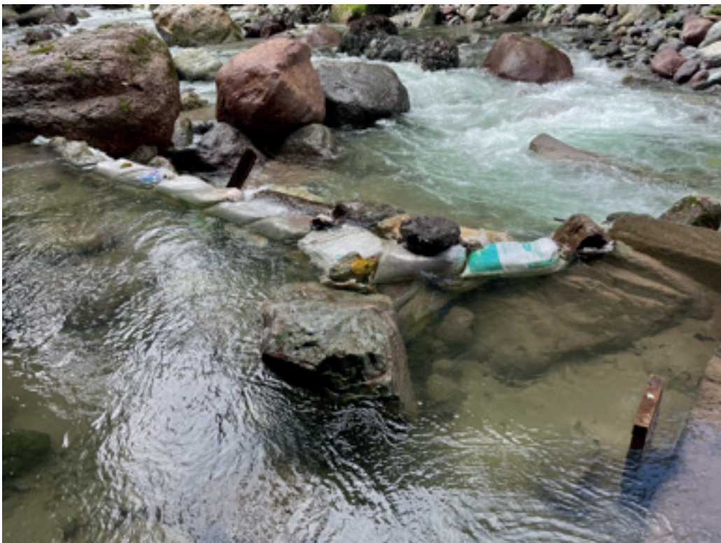
Imagen 10: Reparación temporal con bolsacreto en captación del acueducto urbano La Ceiba
