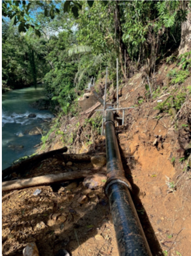
Imagen 9: Reparación temporal de línea de conducción, acueducto urbano La Ceiba
