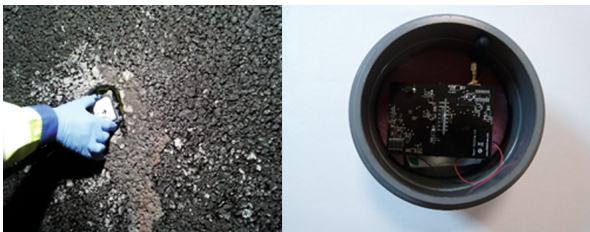
Imagen 4. Sensor de aparcamiento antes de su instalación y sensor de intensidad de tráfico durante su instalación
