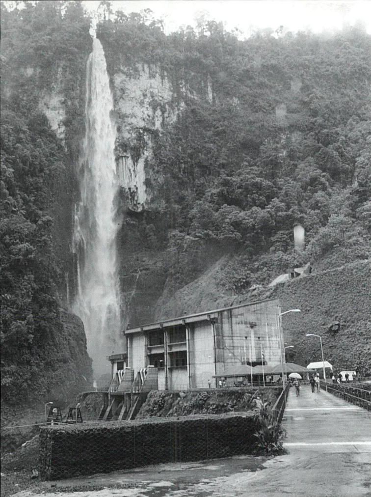
FOTOS DE INSTITUTO COSTARRICENSE DE ELECTRICIDAD
