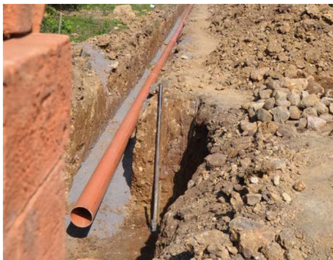
Construcción de sistema de agua potable y saneamiento.
