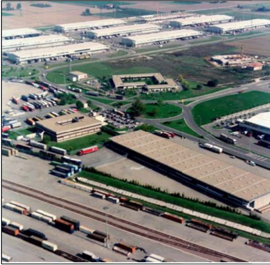
Ilustración 29 Vista aérea del interpuerto de Bolonia.
