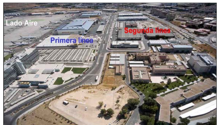
Ilustración 38 Instalaciones del CCA del aeropuerto de Madrid.
