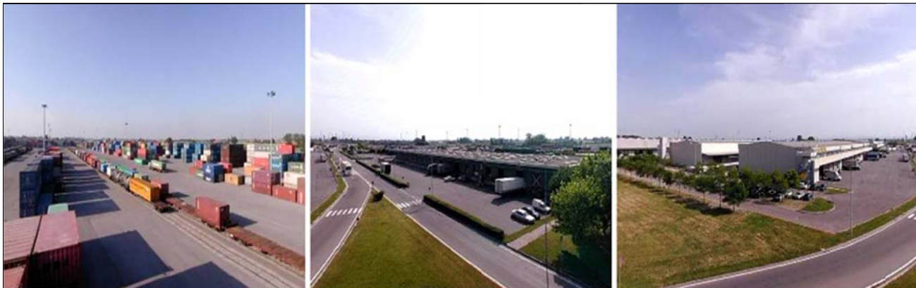
Ilustración 31 Instalaciones del interpuerto de Bolonia.
