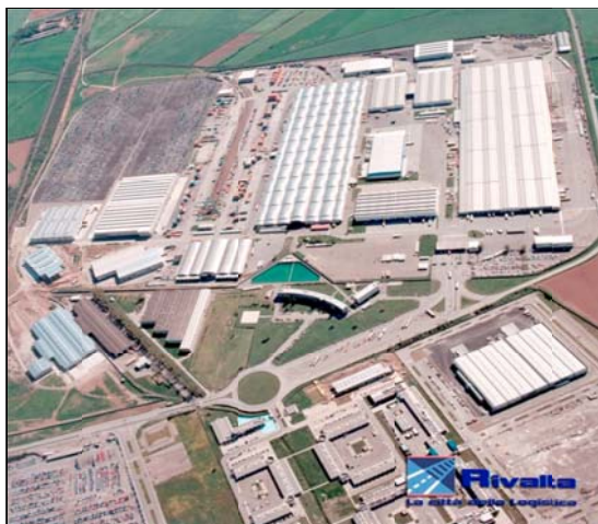
Ilustración 26 Vista aérea del interpuerto Rivalta-Scrivia.
