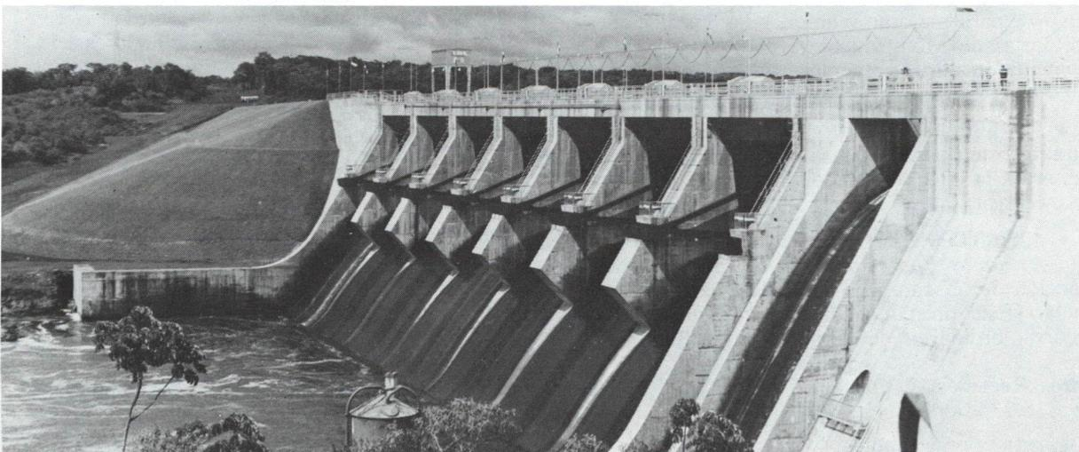
Con ayuda de préstamos del Banco, por un total de \$29.345.000, fue inaugurada el 16 de diciembre la planta hidroeléctrica del río Acaray, en el Paraguay. La planta tiene una capacidad generadora de 45.000 kilovatios y proporcionará energía eléctrica a Asunción y a 43 localidades paraguayas. Se contempla una ampliación de la planta a 90.000 kilovatios y posteriormente a 135.000, y la provisión de electricidad a zonas cercanas de la Argentina y el Brasil.
