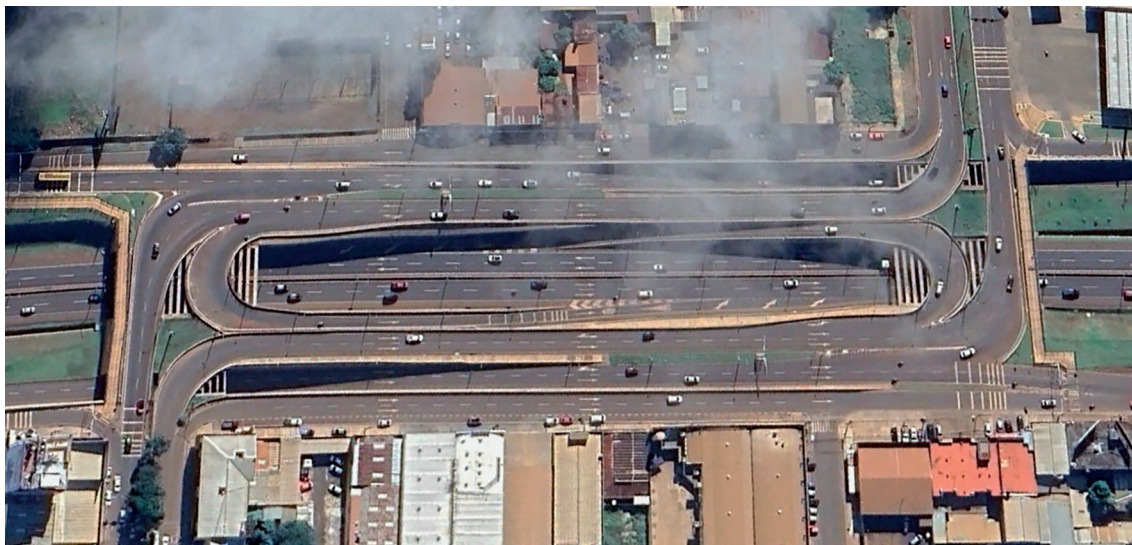
Fotografía 1. Mejora del viaducto del Km 7 en CDE
