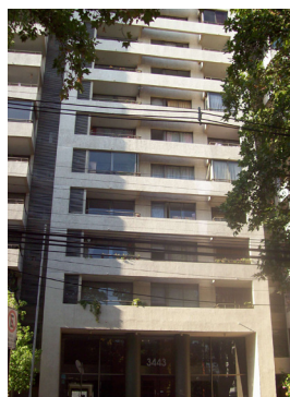
PLAZA ÑUÑOA 140 departamentos 15 pisos 6 años ACS y Calefacción Gas natural
