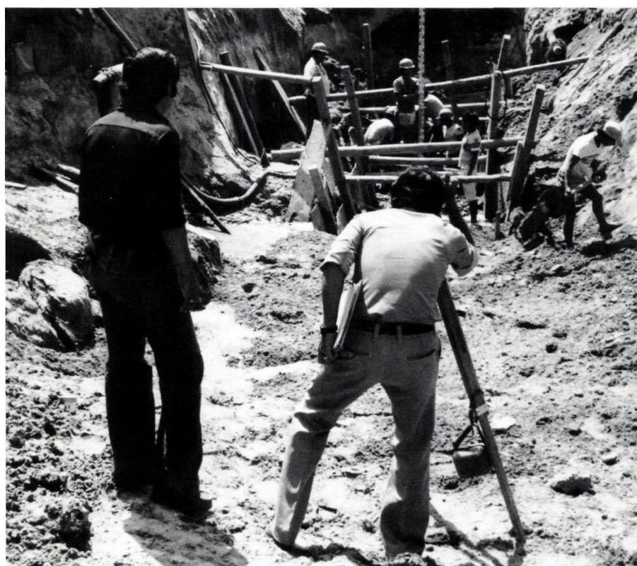
INSTALACION DE NUEVAS tuberías de alcantarillado en el Girón Junín, en Castilla, Perú, en reemplazo de las que fueron dañadas por las inundaciones de 1983. En 1982 el Banco aprobó dos préstamos por un total de \$31 millones para financiar la cuarta etapa de un programa destinado a construir sistemas de agua potable y alcantarillado en pueblos y ciudades del Perú. Posteriormente proveyó ayuda para realizar reparaciones de emergencia en las instalaciones dañadas por las inundaciones.
