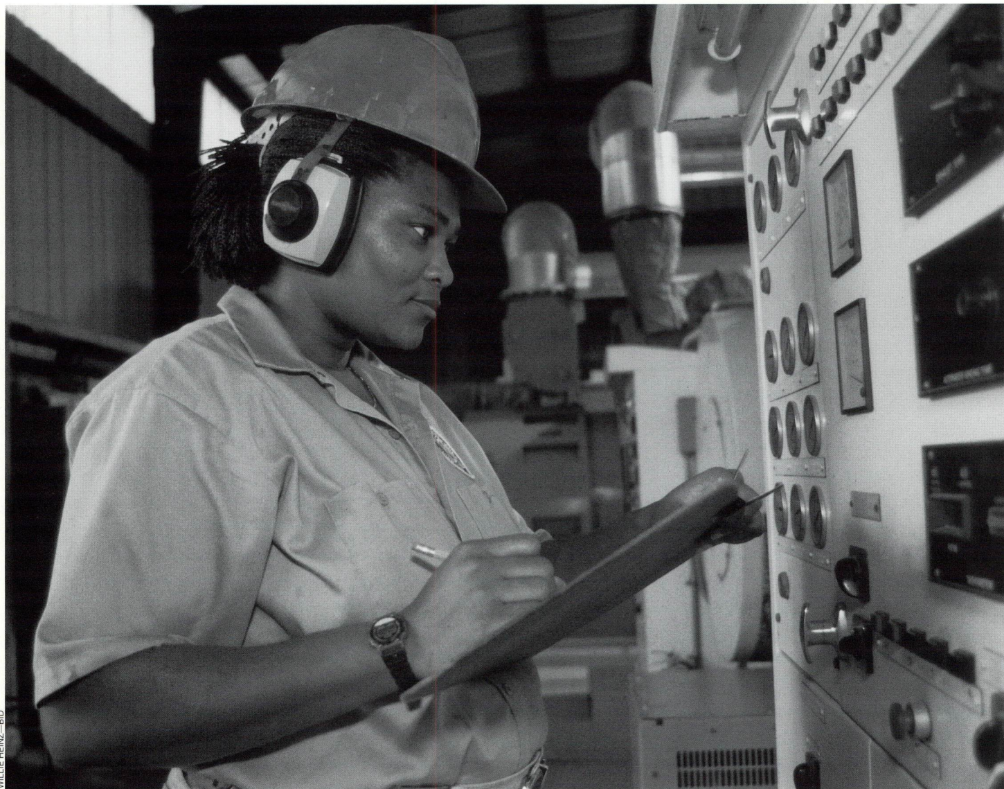
LUCES PRENDIDAS?... La operadora Marlena Frazier revisa los controles de un generador termoeléctrico de 1.670 kilovatios financiado mediante un préstamo del BID y puesto en marcha a principios de 1998 en la isla de Bimini en las Bahamas.
