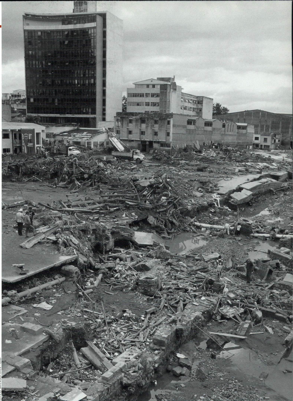
SIN HOGAR: Las aguas y los deslizamientos barrieron con muchos de los refugios improvisados donde se juntaban los niños de la calle de Tegucigalpa.
