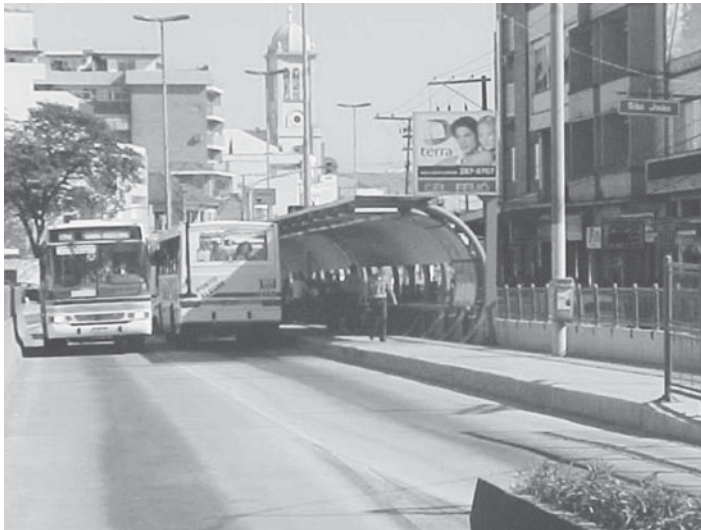
Foto 2. Parada de autobuses en la vía exclusiva de la Av. Assis Brasil, en Porto Alegre. Los autobuses comunes circulan en el corredor. El piso elevado de la parada reduce las dificultades de embarque y desembarque de pasajeros.
