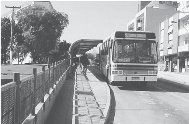
Foto 37. Paradero en el Corredor de la Av. Protásio Alves, en Porto Alegre. El piso elevado tiene la misma altura que el primer peldaño del autobús.
