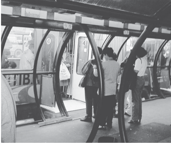
Foto 30. Plataforma de acceso con puente retráctil de los autobuses de Curitiba. Acceso a nivel sin obstáculos.
