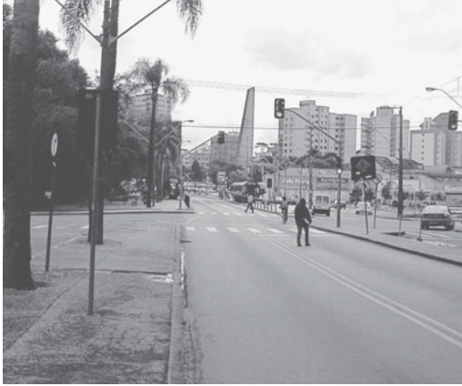
Foto 26. Pista exclusiva en Curitiba. Separada solamente por una acera, permite el acceso de ciclistas y peatones, sin agredir el paisaje.
