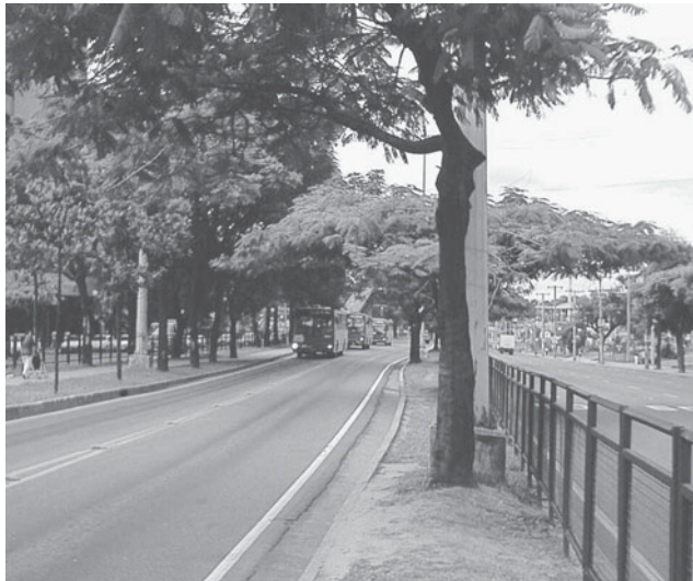
Foto 27. Pista exclusiva en Belo Horizonte. La cerca aísla la pista, permite mayor velocidad a los autobuses y ofrece mayor seguridad; sin embargo, agrede más el paisaje urbano.
