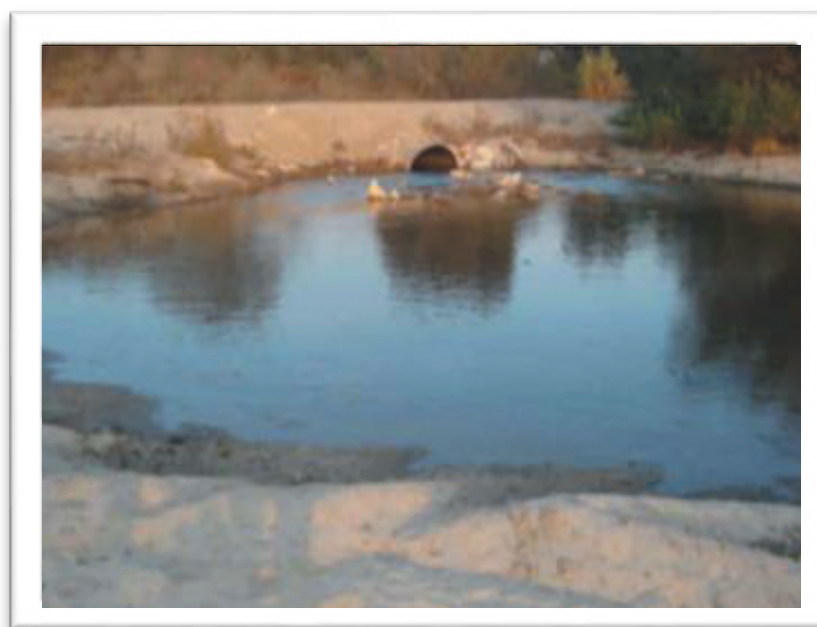
Figura 2: Embalse de recarga en la margen del río (del acervo del autor)
