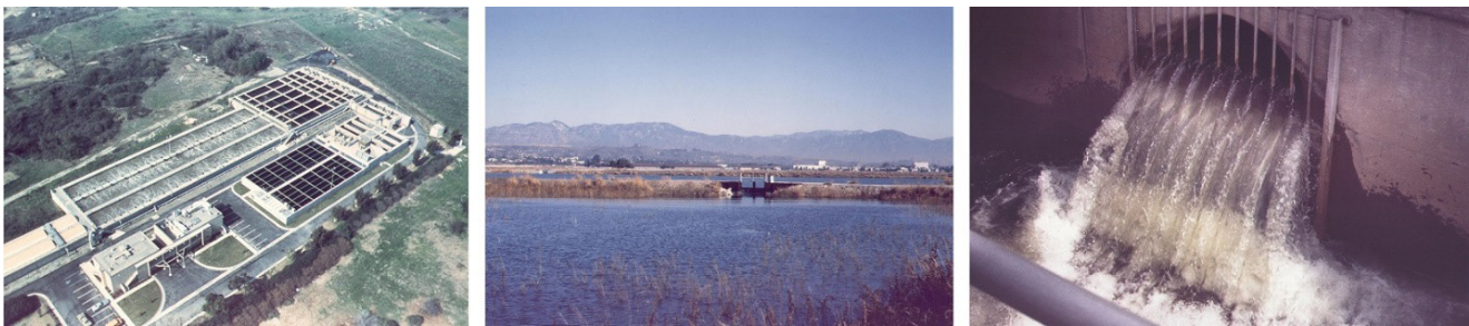
Figura 25: Planta de tratamiento terciario de aguas residuales, embalse de recarga y estructura hidráulica Inlet
