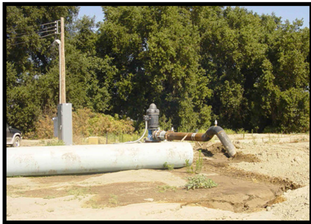
Figura 20: Pozo de recuperación y construcción de tubería de conducción (From Author's Archive)
