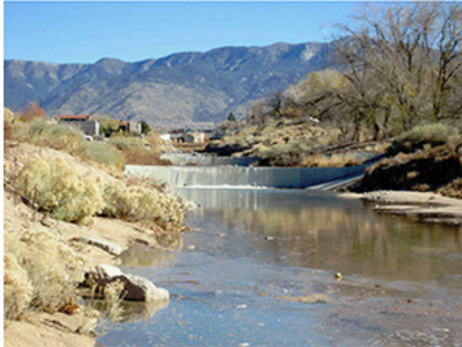
Figura 12. Modificación de cauce en Nuevo México para promover recarga de aguas subterráneas (US Water Alliance, 2016).
