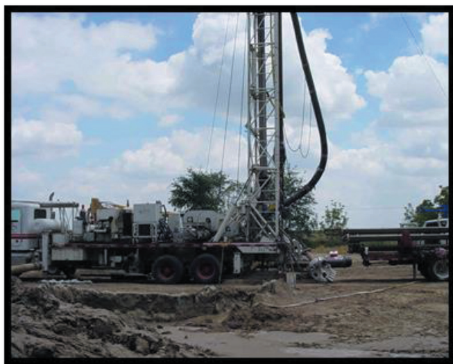
Figura 3: Instalación de pozo de recarga (del acervo del autor)
