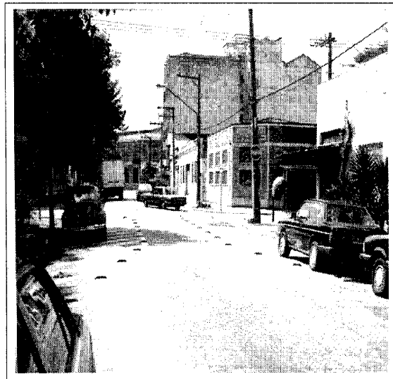
FIGURA 10.32 ESTREITAMENTO DA PISTA EFETUADO COM TACHÕES
