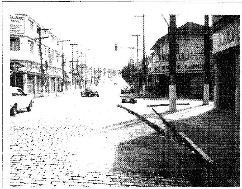
FIGURA 10.9 EXEMPLO DE ESTREITAMENTO GRADUAL RUA SILVA BUENO x RUA COMANDANTE TAYLOR – SÃO PAULO
