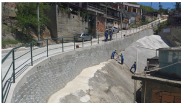
Foto 5 – Contenção de Encostas Realizada no Núcleo Jardim Alvorada, na Comunidade de São José
