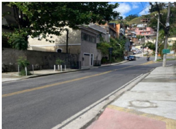
Foto 4 – Pavimentação Realizada no Núcleo Dona Zinha e Avenida Jerônimo Afonso, na Comunidade de São José
