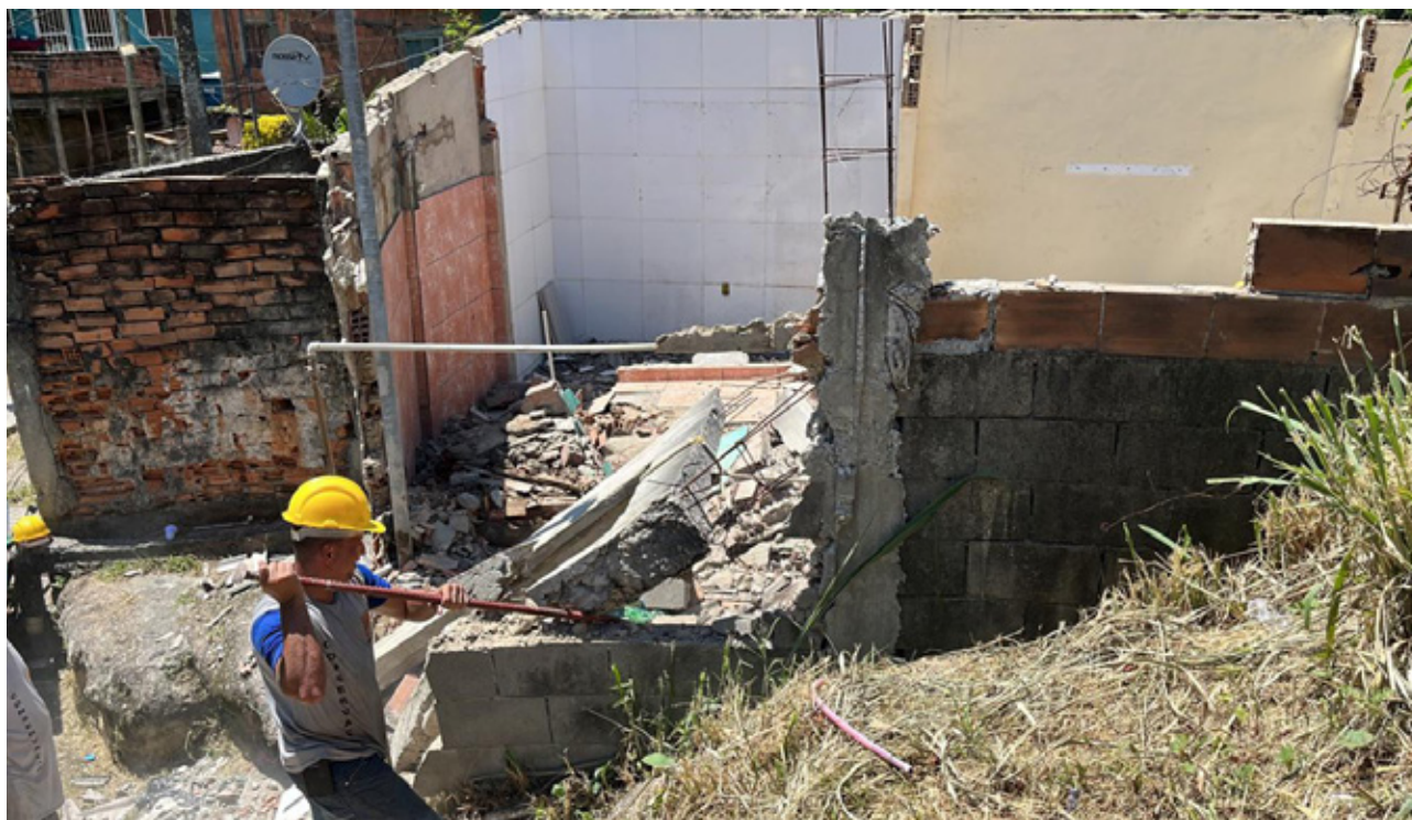
Foto 16 – Demolição do Imóvel
