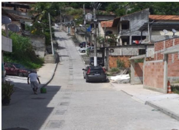
Foto 3 – Pavimentação Realizada na Avenida Jerônimo Afonso, na Comunidade de São José
