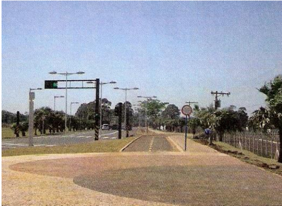
Figura 4: Fotografia de trecho parcial da Via Morena, mostrando passeios e ciclovia
