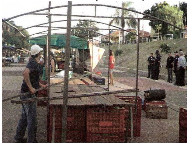
Figura 9: Feirantes instalando suas barracas nos calçadões do Projeto Orla Morena
