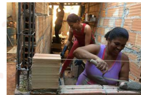
Duas mulheres trabalhando em um canteiro de obras de um projeto da “Arquitetura Na Periferia”. Fonte: Pedro Thiago Silva/ Arquitetura na Periferia
