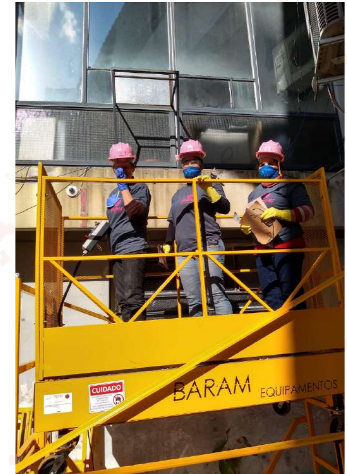
Três mulheres trabalhando em um canteiro de obra da 'Mulher em Construção'. Fonte: Bia Kern/ Mulher em construção
