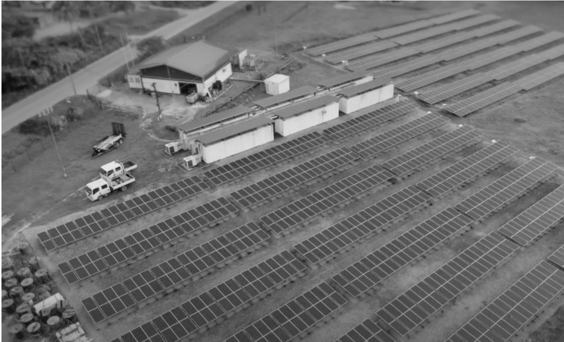
Solar farm in Pokigron.
