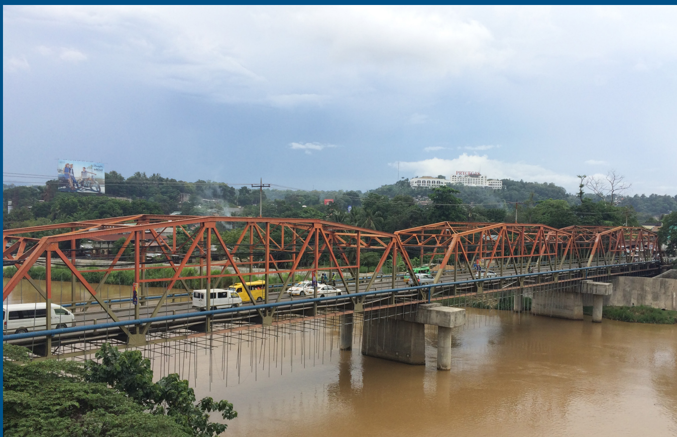
Ysalina Bridge, Cagayan de Oro. M.E.A. Lucas
