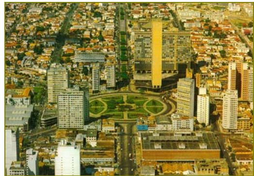
Vista aérea da Praça Raul Soares, Belo Horizonte (Aerial view of the Raul Soares Square, Belo Horizonte), 1973–1975 anonymous From the collection of the Museu Histórico Abílio Barreto, Fundação Municipal de Cultura Photo: Museu Histórico Abílio Barreto, Fundação Municipal de Cultura
