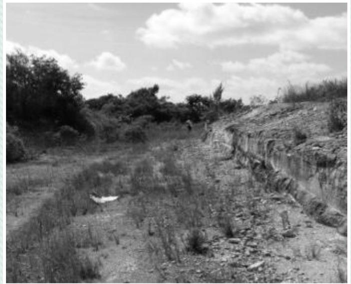
Estanque de lixiviación presuntamente construido, pagado íntegramente por el Programa. El contratista alegó que había revestido el estanque empleando el tratamiento bituminoso necesario para evitar que los residuos peligrosos se filtraran en el suelo y los recursos hídricos cercanos. Si se hubiera utilizado el estanque, algunos residuos peligrosos se habrían filtrado y habrían contaminado el suelo y la capa freática. Debido a varios factores, el vertedero no se utiliza.
