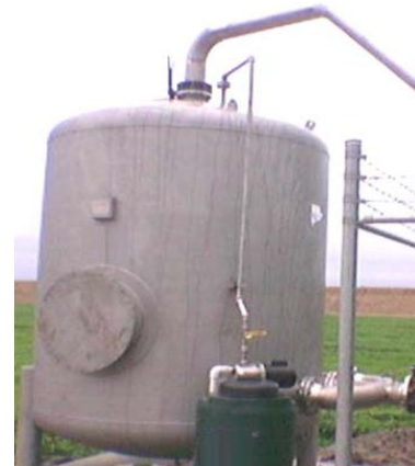
Tanque de remoción de H_2S dentro del cual se encuentran las esponjillas.
