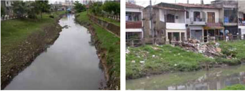
Floods and maintenance of the river canals, and sedimentation (Photos: Mr. José Alexandre, member of the Comissão de Fiscalização do Programa Bacia da Una –Sub-Bacia 1 [Villa Freitas].)
